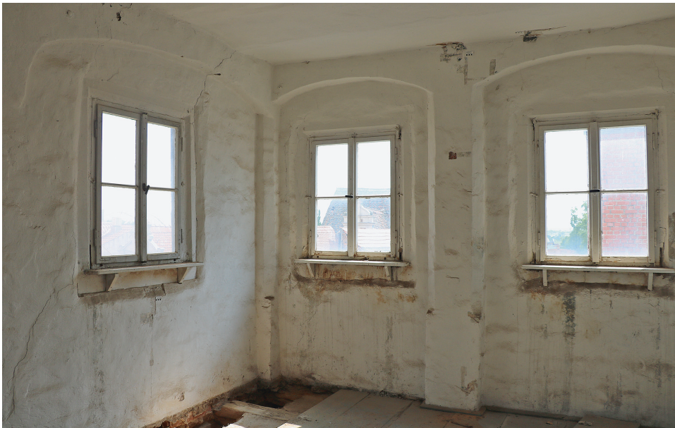
Abb. 13c: Wittenberg, Markt 3, Wohnhaus, Belvedere, Fenster nach Osten und Süden (Foto: Insa Christiane Hennen, 2018).
