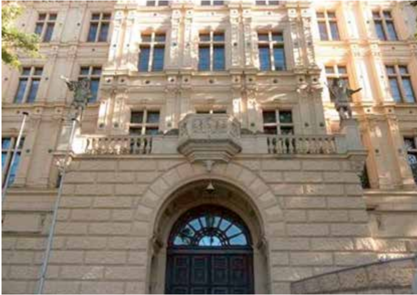
Abb. 6: Schwerin, Schloss, Ansicht des Portals vom Burggarten (Foto: Melanie Ehler, 2015)
