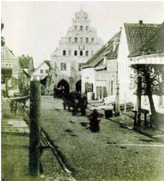
Abb. 5: Barth, Blick von der Langen Straße auf den 1654 umgestalteten Südgiebel des Rathauses, o.J., historisches Foto. Barth, Stadtarchiv (Stadt Barth [2005], S. 66, Abb. 66.2)
