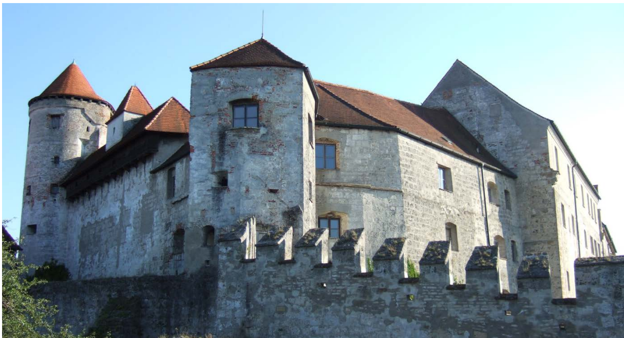
Abb. 5: Burghausen, Blick auf die Toranlage zur Hauptburg mit hölzernem Wehrschirm (vgl. Pos. c in Abb. 3) (Aufn.: Stephan Hoppe 2005)
