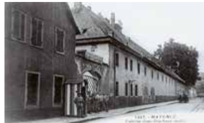
Abb. 94: Lagergebäude des Bauhofs an der Mittleren Bleiche mit Blick nach Südosten, Stadtarchiv Mainz, BPSF / 17626 A
