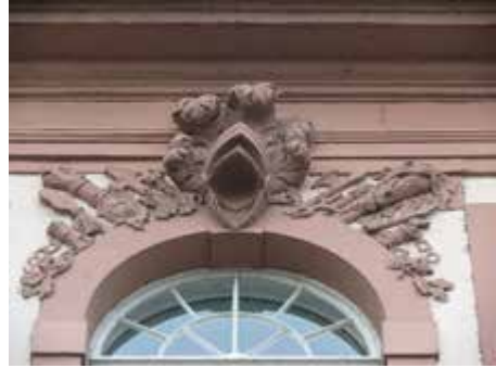
Abb. 125: Mainz, das Neue Zeughaus, Fensterzier im ersten Obergeschoss
