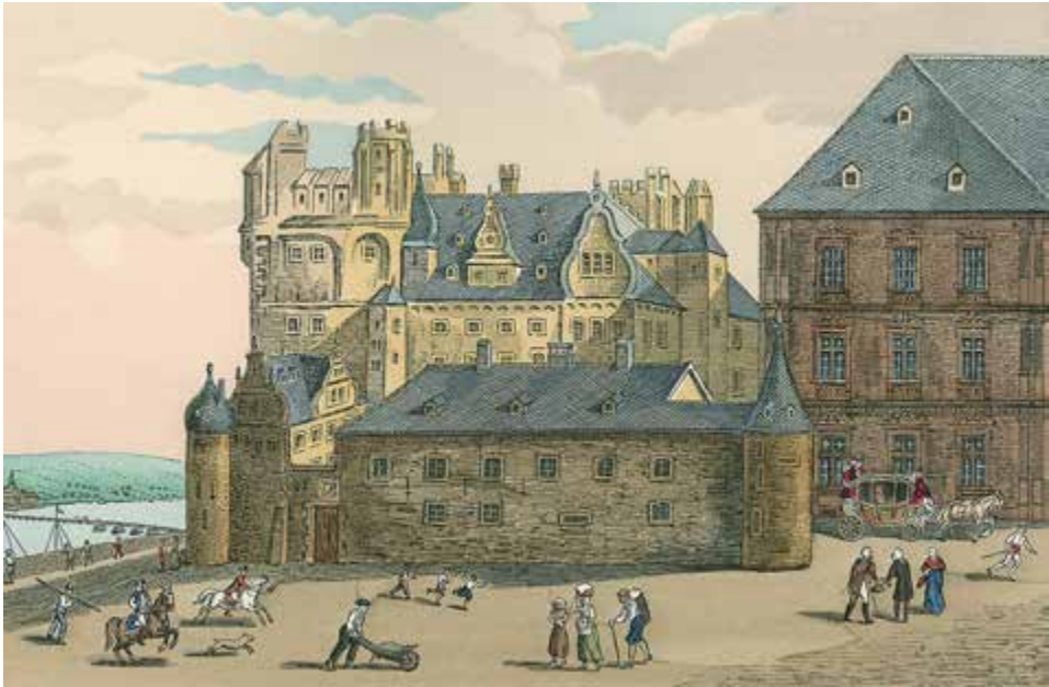
Abb. 82: Franz von Kesselstatt: Die Martinsburg von Norden, Deckfarbenmalerei, nach 1806, Landesmuseum Mainz, GDKE, Inv. Nr. GS 0/2084
