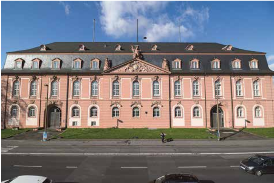
Abb. 122: Mainz, das Neue Zeughaus von der Rheinseite
