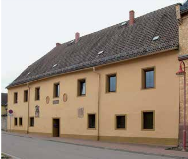
Abb. 4: Mansfeld, ehemaliges Oberspital von Osten (Foto: Sascha Winter, 2015)
