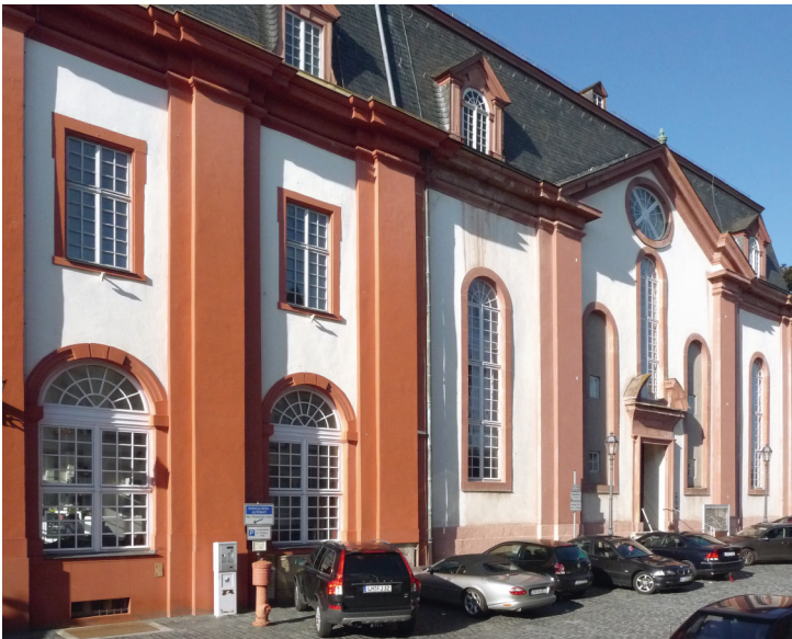
Abb. 17: Weilburg a. d. Lahn, Südseite des Rathauses und der sich anschließenden Kirche. Aufnahme: Verfasser.
