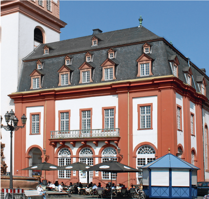
Abb. 16: Weilburg a. d. Lahn, Fassade des Rathauses von Westen. Bildarchiv des Verfassers.
