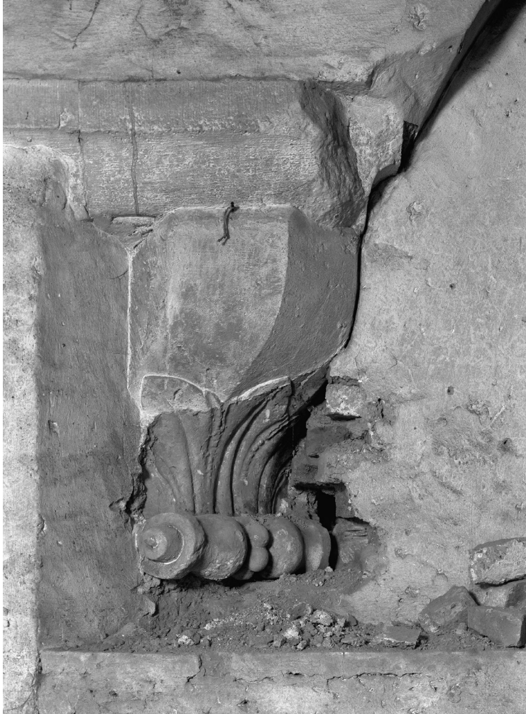
Abbildung 3: Pfeilerkapitell der Ostwand der Saalkirche, freigelegt 2001 (Landschaftsverband Westfalen-Lippe, Denkmalpflege, Bildarchiv, Foto: Hartwig Dülberg).
