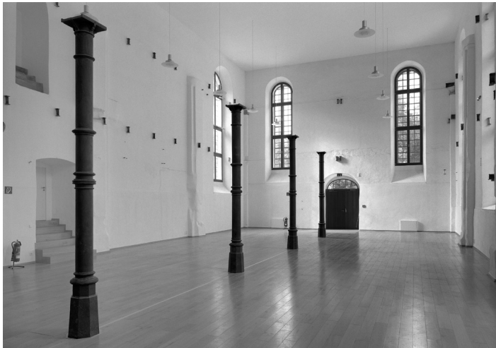
Abbildung 2: Innenansicht der Klosterkirche nach Südwesten. Die in die Wände eingelassenen Eisenträger dienen als Stützkonstruktion für Zwischendecken. Die gusseisernen Stützen sind erst 1851 nach Stilllegung des 1828 zur Herstellung von Roheisen und Eisengusswaren aufgestellten Hochofens eingebaut worden, um den mit Zwischenböden ausgestatteten einschiffigen Saalkirchenraum zu Magazin zwecken nutzen zu können (Landschaftsverband Westfalen-Lippe, Denkmalpflege, Bildarchiv, Foto: Greta Schüttemeyer, 2005).
