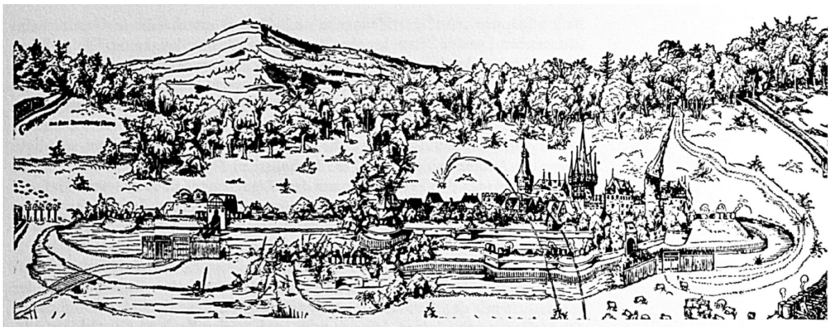
Abbildung 2: Ansicht Wolfenbüttels von Norden (Ausschnitt aus Abbildung 1)
