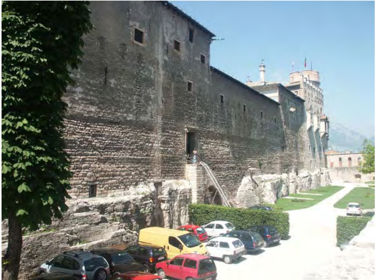
Abb. 5: Stadtmauer im Verlauf der Vorburg
