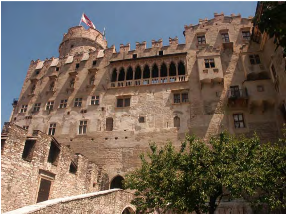
Abb. 12: „Venezianische“ Loggia, rechts der älteste Wohnbau. Die Schwalbenschwanzzinnen zeigen die mehrfachen Aufstockungen
