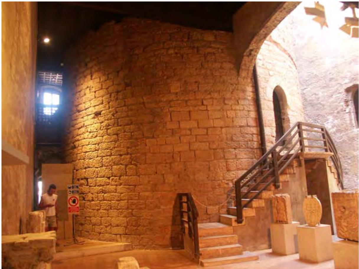
Abb. 7: Eingangsgeschoß des Bergfrieds über einem hohen, heute unzugänglichen Sockel. Das Portal ist leicht spibogig (um 1250/60?)
