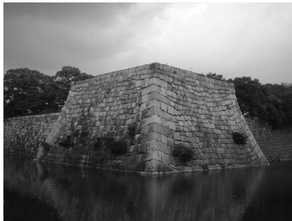
Abb. 10: Leeres Fundament des Hauptturms, Schloßburg Nijô, Kyôto Quelle: http://www4.airnet.ne.jp/kmimu/castle/kinki/nijyo65.jpg
